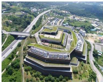
40MW급 네이버 데이터센터(춘천)
